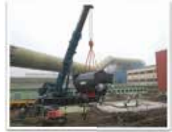
Vzdušný transport na místo budoucí kotelny
