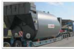
Návoz plynového kotle 28 MWt z Německa do Pruněřova
